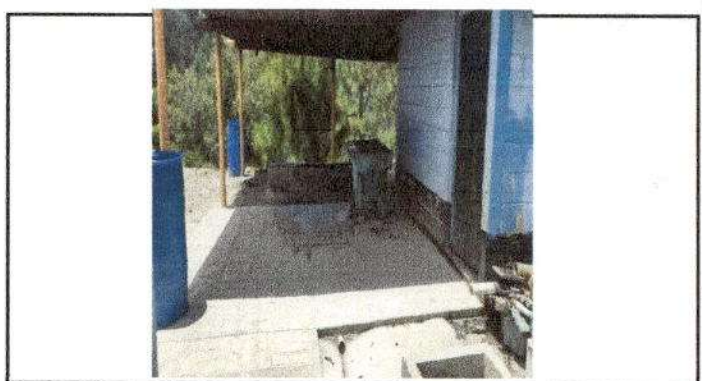
Foto 6: Reparación de losa de patio de cocina.
