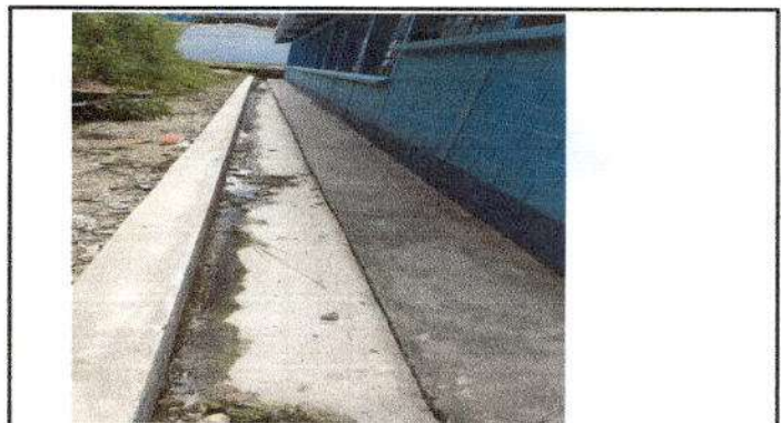
Foto 4: Reparación de cuneta de concreto.
