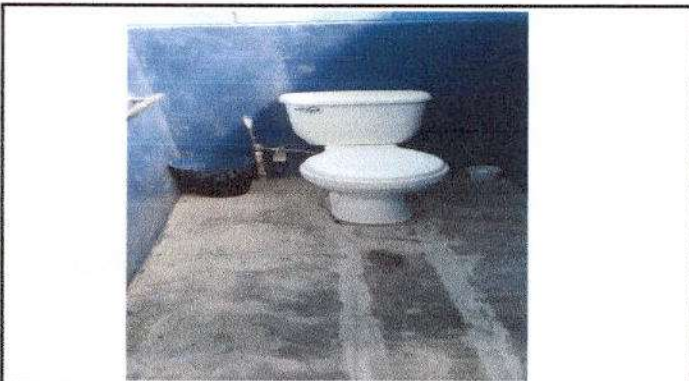
Foto 3: Sustitución de inodoro.
