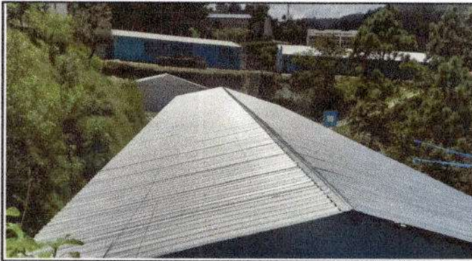
Foto1: Sustitución de lamina por lamina troquelada.
