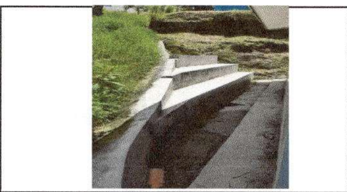
Foto 5: Reparación de cuneta.
