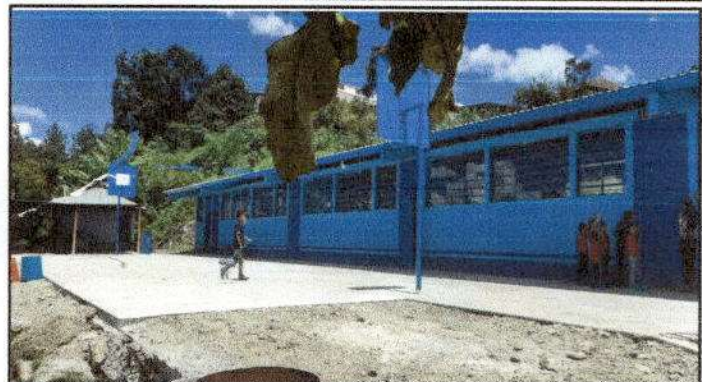
Foto 2: Sustitución de torta de concreto.
